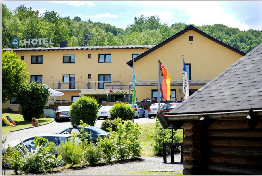
Außenansicht Waldhotel Felschbachhof
