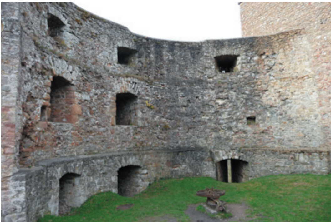
Innenansicht des Rondells von Südwesten mit Schießscharten in drei Ebenen. Dahinter die Giebelmauer des älteren sog. Ostpalas angeschnitten (Foto: Verf. 2010).
