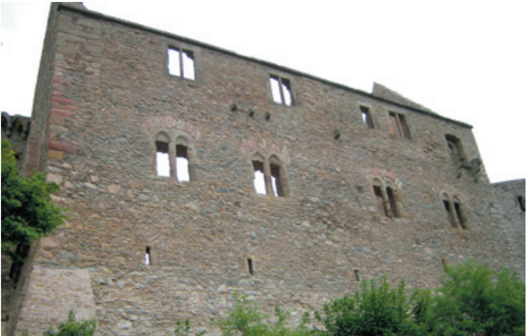
Sog. Ostpalas von Norden. Im Obergeschoss sind die Baufugen der Giebelwand zu erkennen, die auf ein früheres Fachwerkobergeschoss hindeuten (Foto: Verf. 2007).
