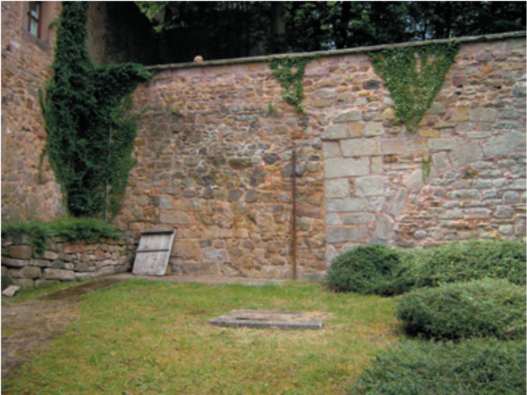
Ehemalige Zugbrücke über den Graben von Süden. Rechte Bildhälfte mit dem ehemaligen Brückenpfeiler, links davon der nachträglich vermauerte Brückenkeller (Foto: Verf. 2009).
