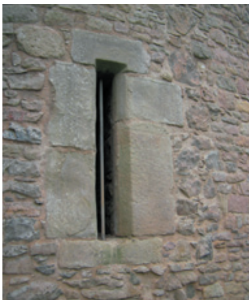
Für Feuerwaffen konzipierte Schlitzscharte des Rondells (Foto: Verf. 2010).
