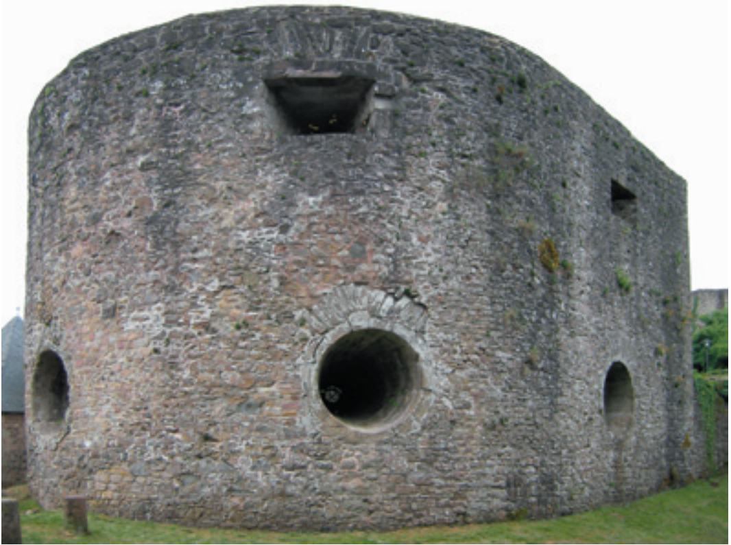
Sog. Hufeisen- oder Spanierturm von Osten (Foto: Verf. 2007).
